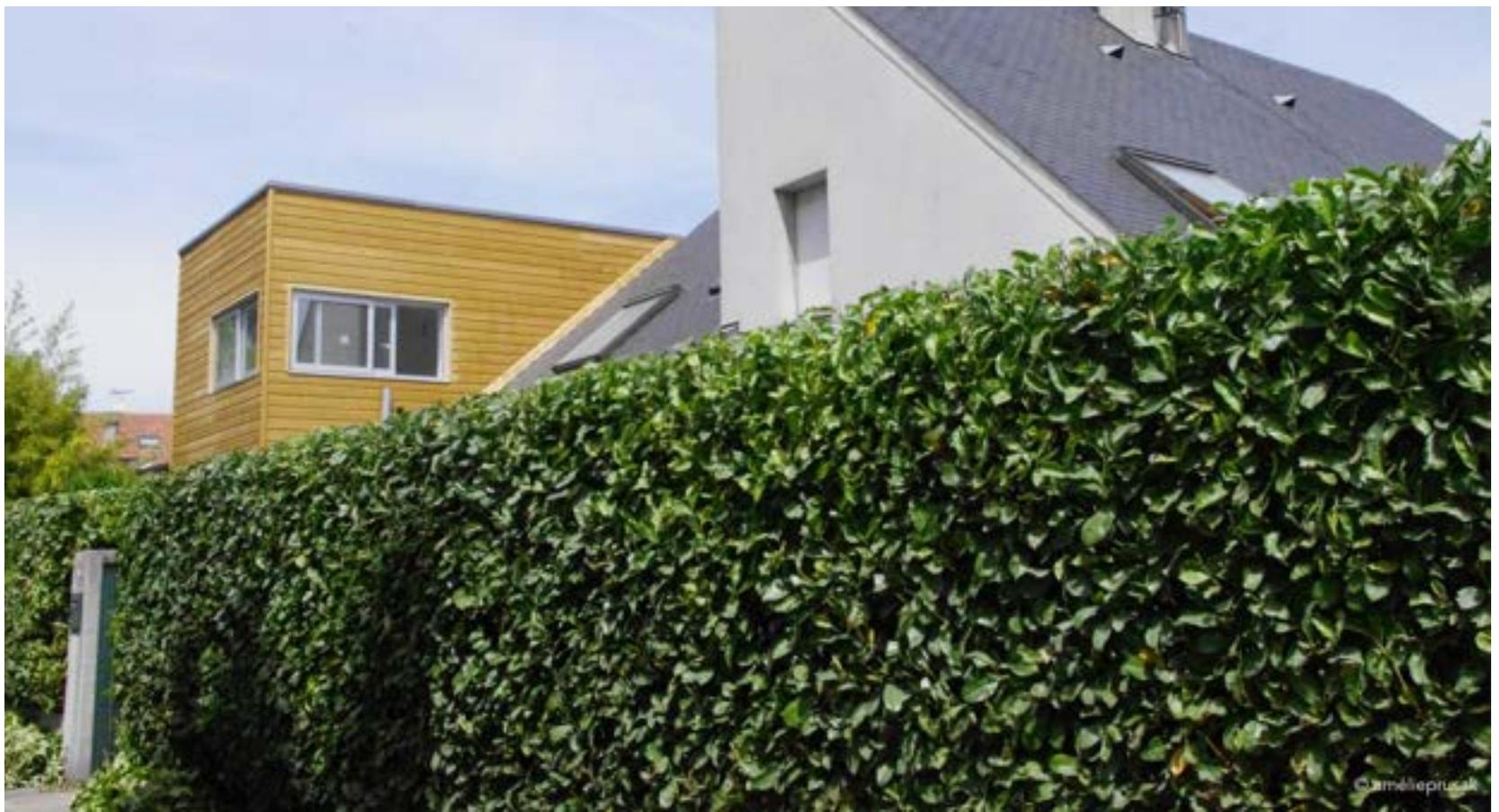
Afin de conserver l'emprise foncière et le jardin, l'agence a proposé la création d'une extension au 1er étage de la maison. Réalisée en structure et bardage bois, l'extension est posée à la fois sur le garage et sur des poteaux bois. Après 4 mois de travaux, l'extension offre 2 chambres supplémentaires, sur un étage entièrement dédié aux enfants, offrant luminosité et fluidité des circulations.
